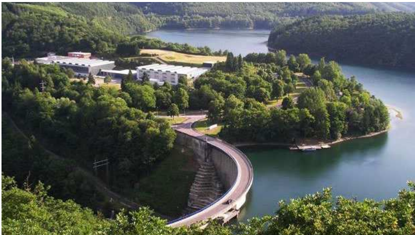
_Talsperre Esch/Sauer mit der heutigen Trinkwasseraufbereitungsanlage des SEBES
